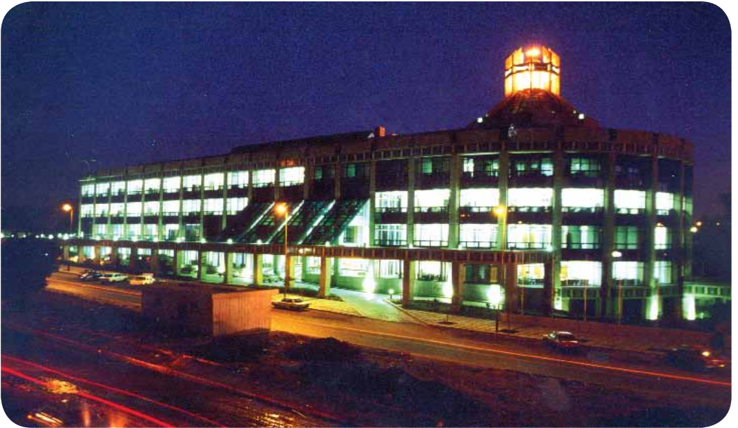
صورة ليلية للمبنى
