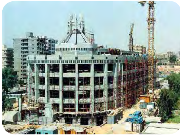
مبنى إنبى تحت الإنشاء
